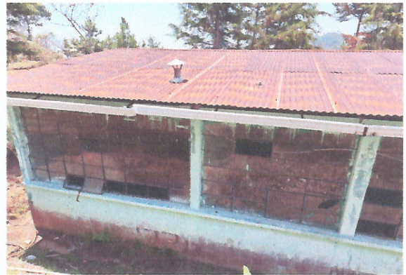
Foto 4: ÁREA PARA MEJORAR E INSTALAR BALCONES Y REPARACIÓN DE VENTANAS.
